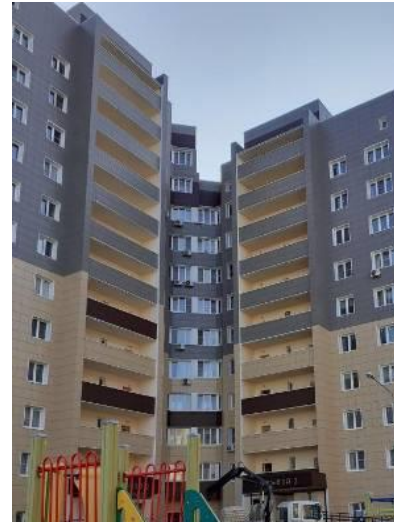
Фото. 4. Внешний вид жилого дома
