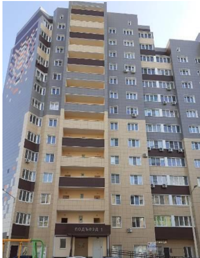
Фото. 3. Внешний вид жилого дома
