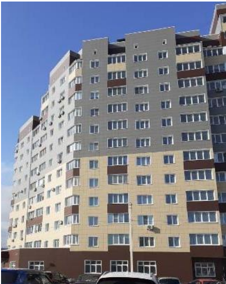
Фото. 2. Внешний вид жилого дома
