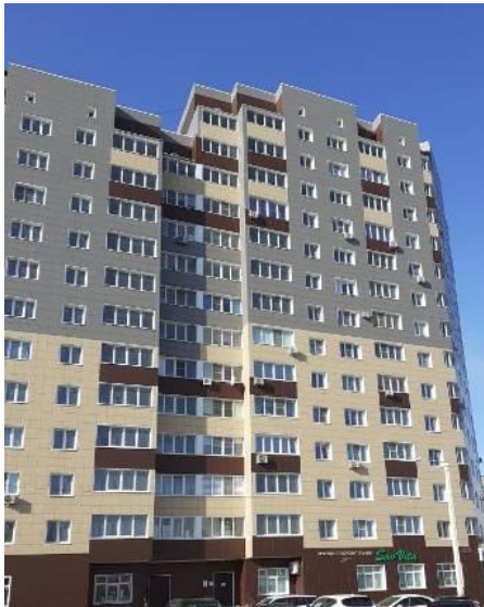
Фото. 1. Внешний вид жилого дома
